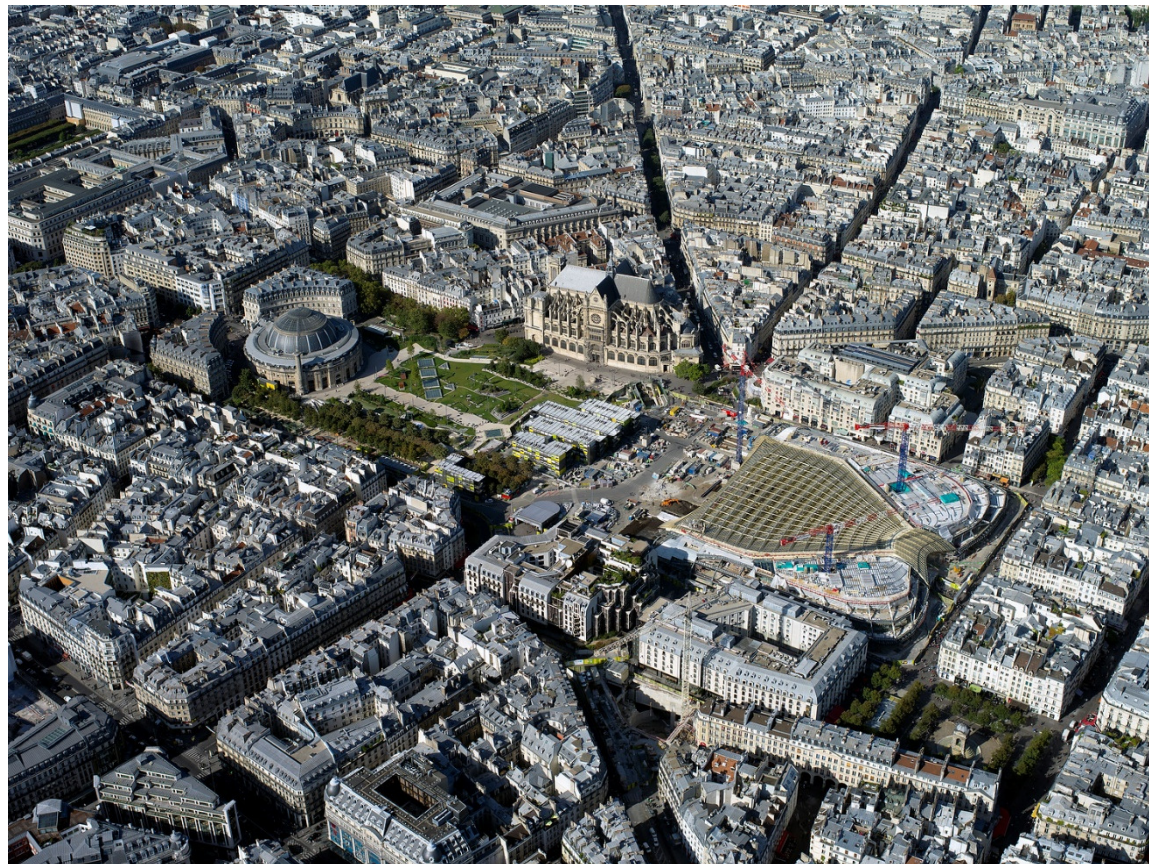
Vues aériennes – chantier été 2014
